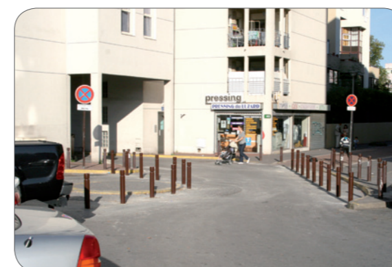
La place de l'Horloge après travaux.
