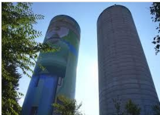
Les châteaux d'eau des Totems
